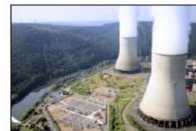
1 - Chooz Ardennes, à 60 km de Charleville-Mézières Réacteur à eau pressurisée Mise en service : 1967 Date d'arrêt : 1991
