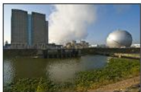
4 - Chinon A Indre-et-Loire, à 45 km de Tours 3 réacteurs UNGG Mises en service 1963, 1965 et 1966 Dates d'arrêt : 1973, 1985 et 1990
