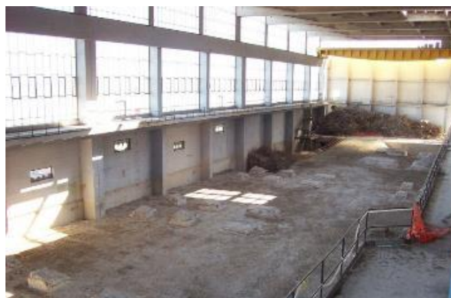
Edificio turbine dopo i lavori di decontaminazione e smantellamento dei componenti metallici
