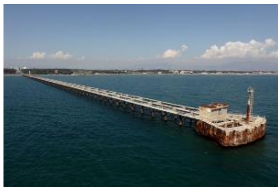
Il pontile prima della demolizione
