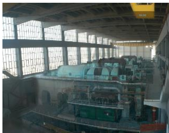
Edificio turbine prima dei lavori di decontaminazione e smantellamento dei componenti metallici
