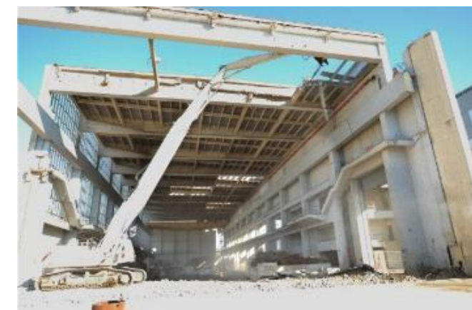
Smantellamento dell'edificio turbine
