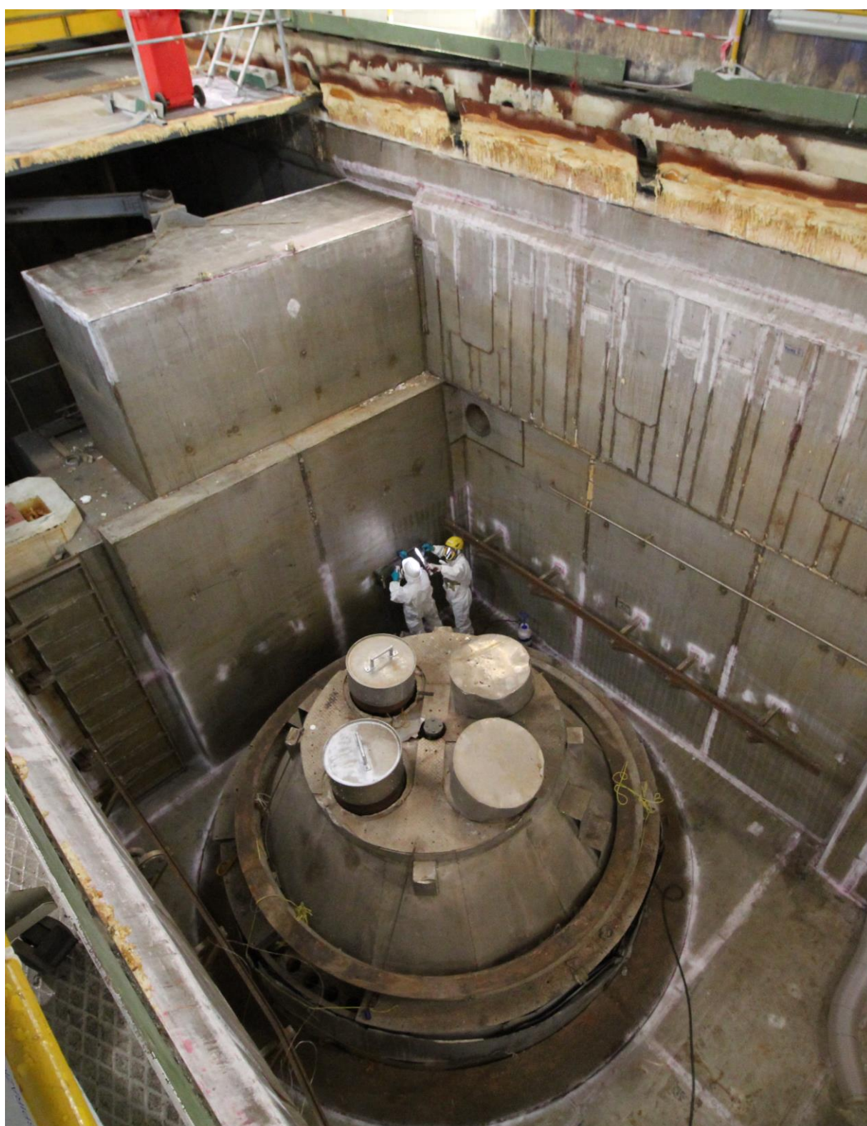
Predisposizione aree di lavoro nel canale reattore
