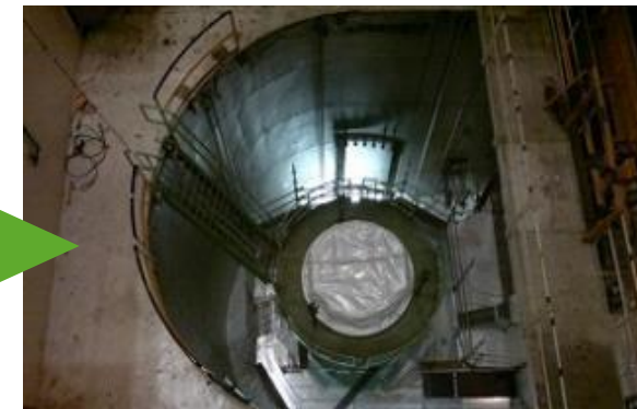
Testa del Vessel dopo la rimozione dell'amianto
