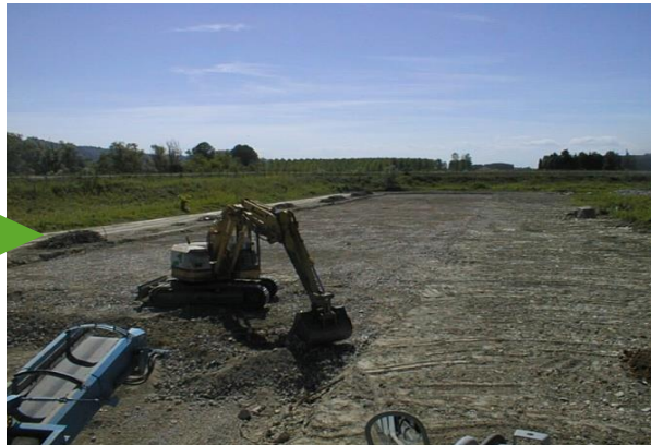
Smantellamento torri di raffreddamento
