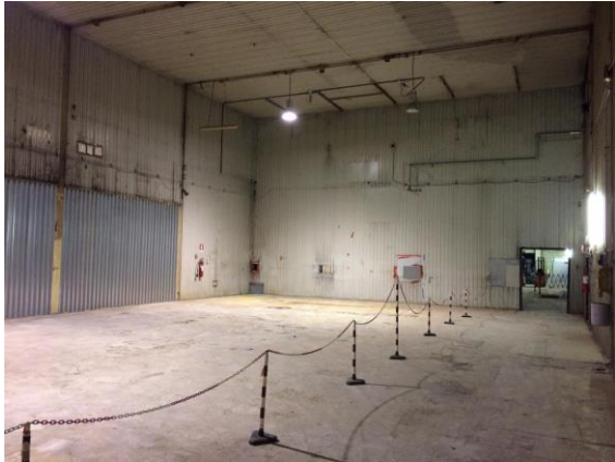
Smantellamento dei sistemi ausiliari di impianto (ventilazione, etc...)
