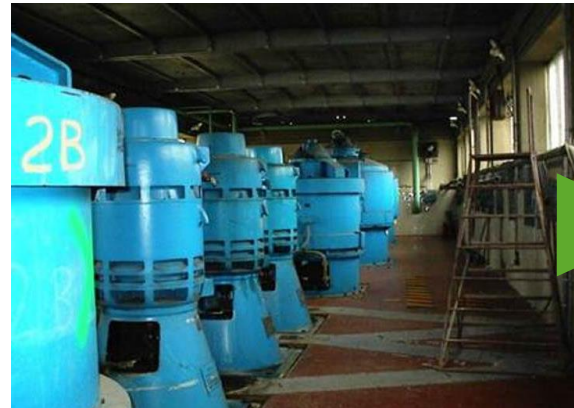
Opera di presa prima dello smantellamento
