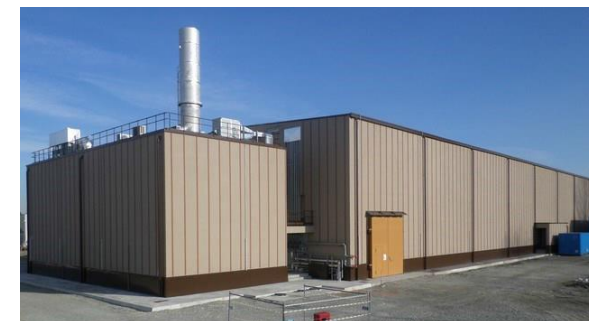
Deposito temporaneo D2
