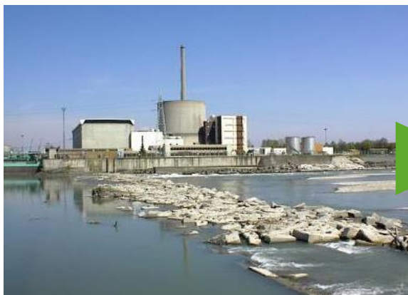
Traversa sul Po prima dello smantellamento
