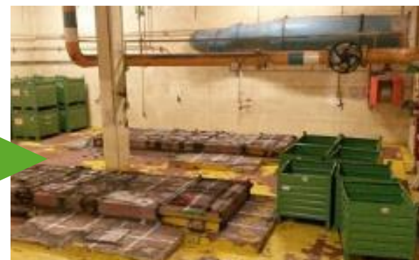
Aree di lavoro dopo lo smantellamento e cassoni per materiali
