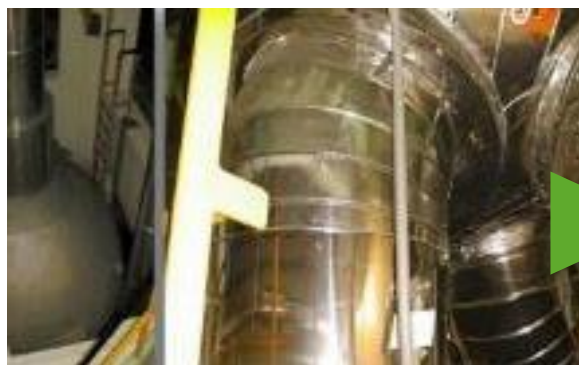
Smantellamento componenti non contaminati e rimozione dei coibenti pericolosi
