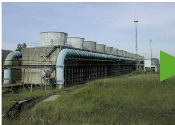
Torri di raffreddamento prima dello smantellamento
