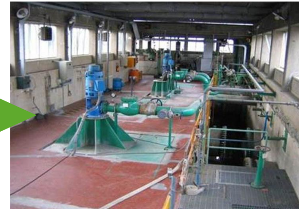
Opera di presa dopo lo smantellamento
