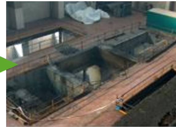
Smantellamento turbine e alternatori
