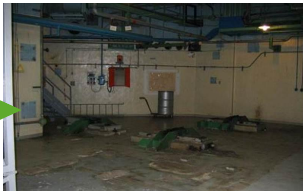
Locale scambiatori dopo lo smantellamento
